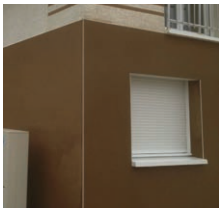
Exemple de réalisation de façade en enduit avec baguette d'angle
