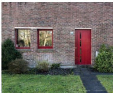
portes et menuiseries rouges
