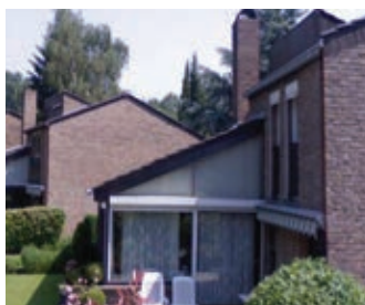
volets roulants apparents
