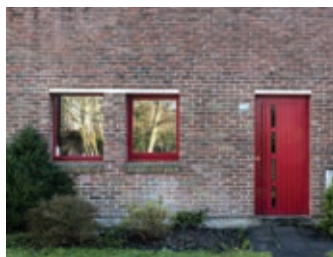
portes et menuiseries rouges
