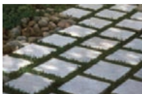
Pavés à joints engazonnés
