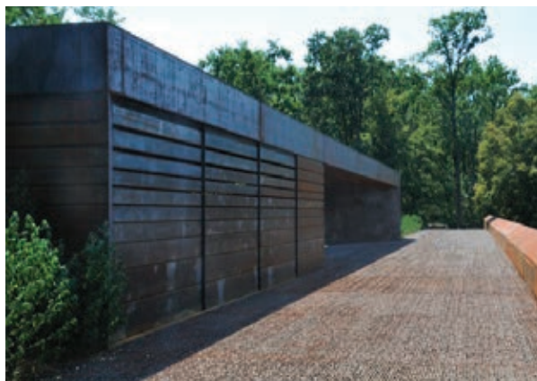
partie annexe extérieure en bois peint en noir mat accolée à l'habitation
