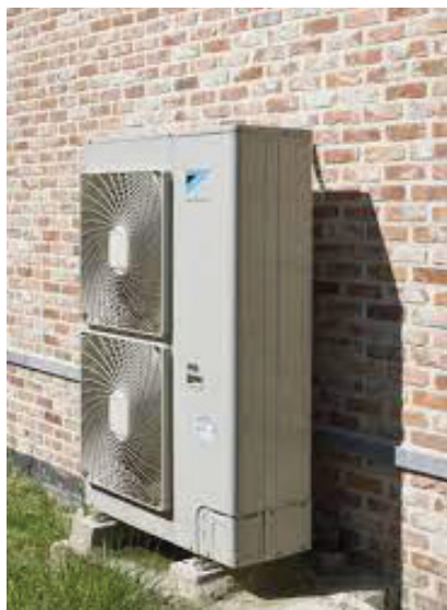
Exemple de modules extérieurs de PAC
