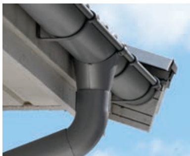
gouttière et EP PVC rondes peu qualitatives
