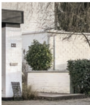
descente d'eau assortie au mur blanc
