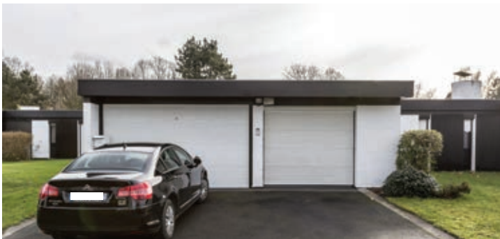
carport fermé par porte PVC, hétérogène par rapport à la porte du garage et l'architecture de la maison
