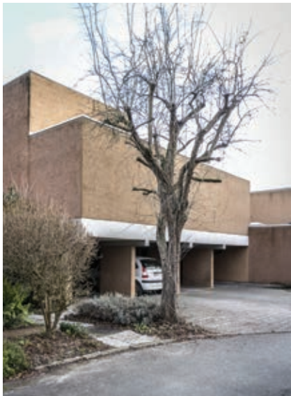
MAISON SUR GARAGE: STATIONNEMENT DANS L'EMPRISE DU BÂTIMENT
